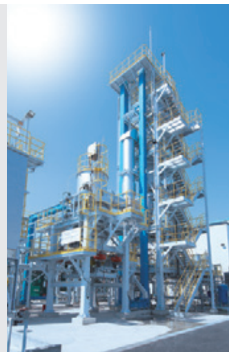
吉川再生可能エネルギーセンター
