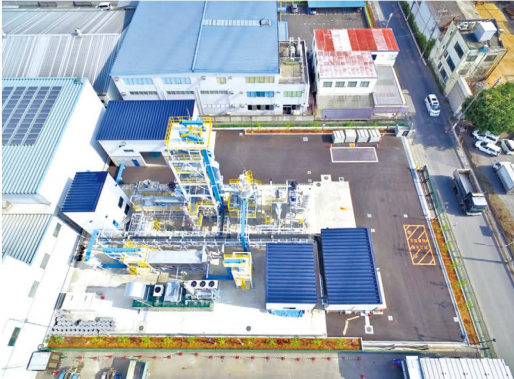
吉川再生可能エネルギーセンターの全景
